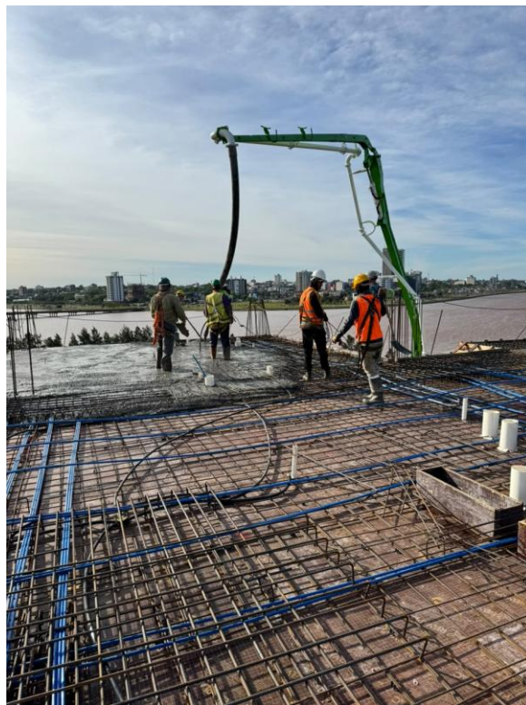
Hormigonado de losa N6
